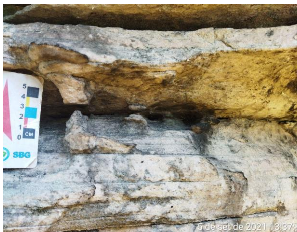
Figura 8 – Canalículos formados devido ao escoamento temporário de água. Fonte: elaborado pelos autores.
